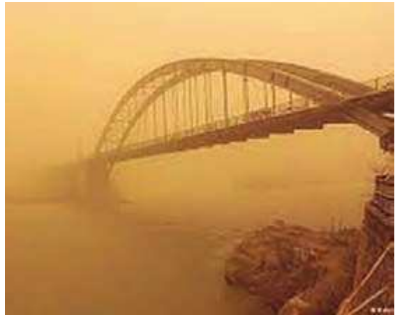
شکل ۳- الف) آلودگی ناشی از ریزگردها- اهواز
