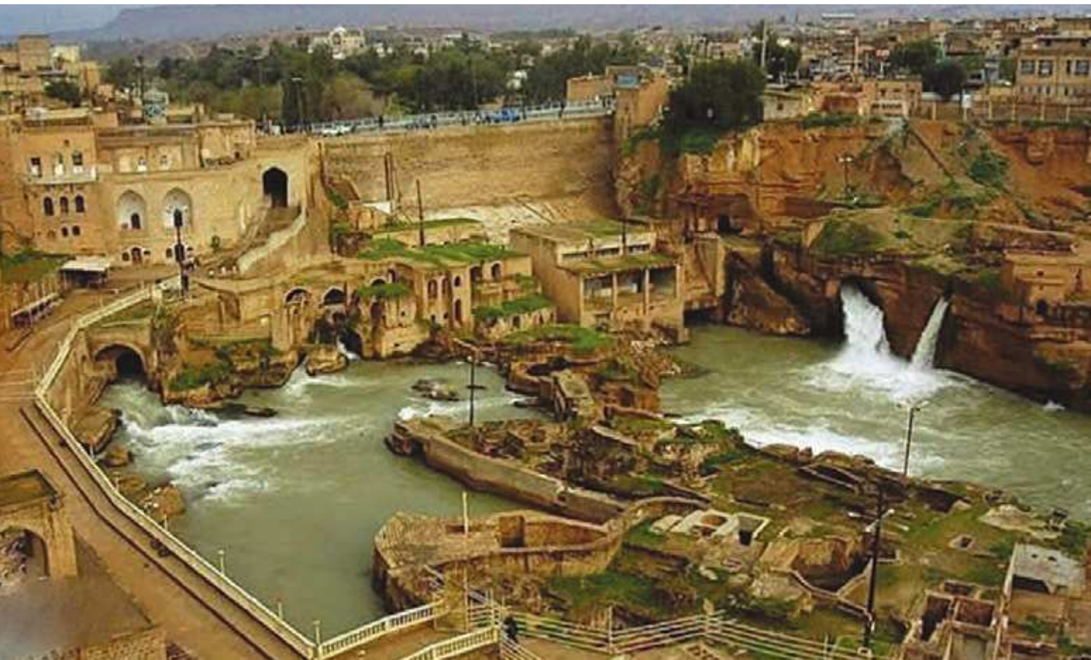
شکل ۵- سازه‌های آبی - تاریخی، شوشتر، خوزستان
