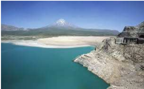
شکل ۹- سد لار در تهران، در مکان مناسبی احداث نشده است.
