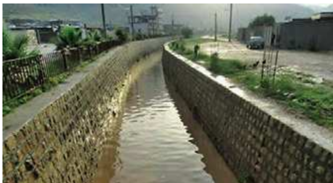
هدایت و انحراف جریان سیلاب رودخانه توسط کانال‌های فرعی در مسیر زاینده رود دیواره حائل برای حفاظت از سکونتگاه‌های حاشیه رودخانه گرمابدره سرشاخه جاجرود در استان تهران
