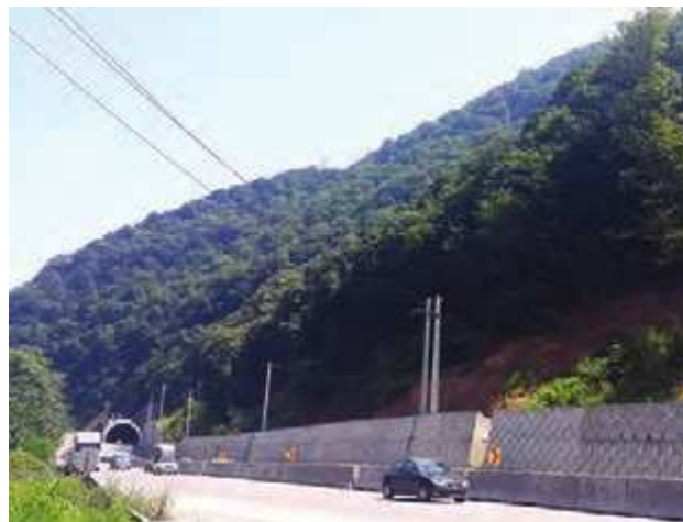
نصب حفاظ بتونی - جاده قائم‌شهر
