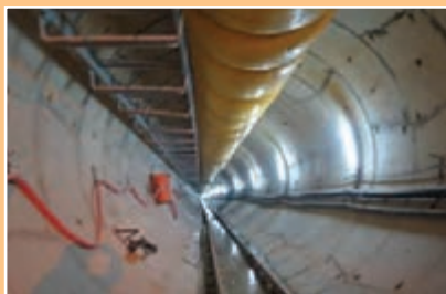
تونل انتقال آب (تونل کانی سیب - پیرانشهر)
