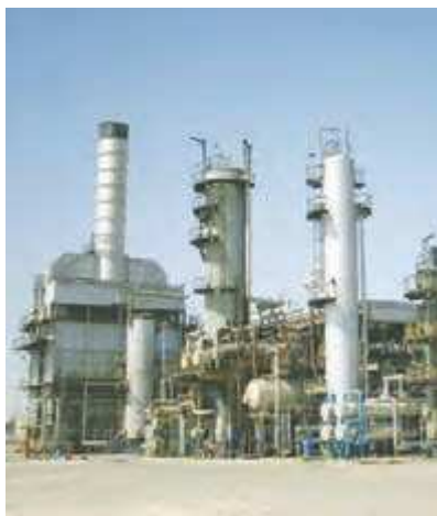
ب) نمای بیرونی برج تقطیر در پالایشگاه
