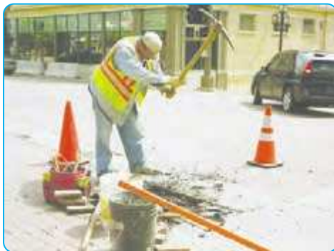
استفاده از کلنگ در کندن زمین
