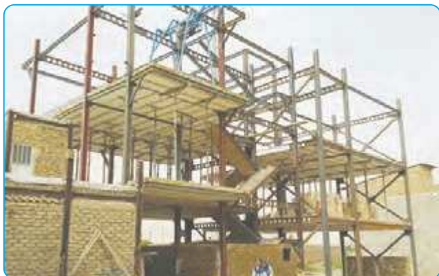
خانه‌ی در حال ساخت
