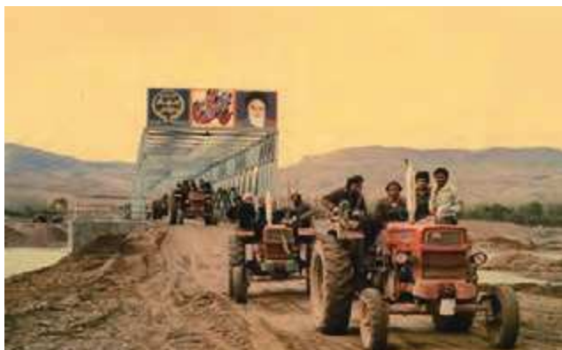
احداث پل وحدت در منطقه کردستان از اقدامات جهاد سازندگی در دوران دفاع مقدس
