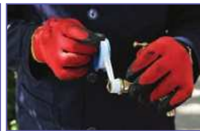
پ- پیچیدن نوار تفلون روی شیر نو
