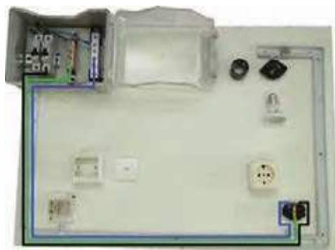
شکل ۱۰-۶- انجام سیم‌کشی پریز ۱
