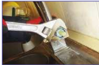
ث- باز کردن پیچ روی مغزی (گلند)
