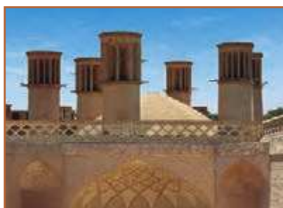
الف- استفاده از آجر در ساختمان‌های قدیمی
