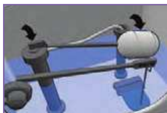
ت - اطمینان از بستن آب ورودی توسط شناور در زمان پر شدن مخزن
