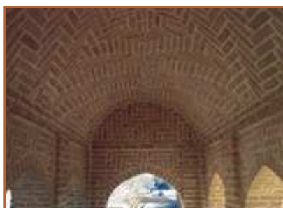
ب- استفاده از آجر برای سقف قوسی
