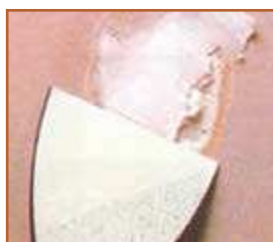
ب- لکه گیری و ترمیم ترک‌ها
