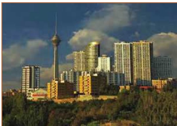
الف - ساختمان سازی
