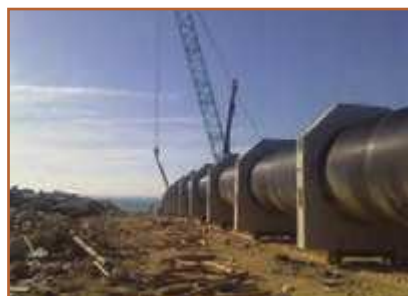
ت - احداث خطوط لوله
