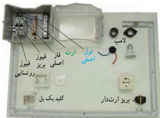
شکل ۶-۷ - پیاده کردن نقشه، جانمایی و داکت‌کشی
