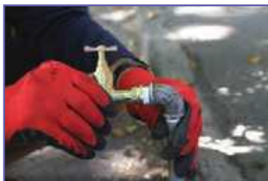
ت- بستن شیر با دست به لوله
