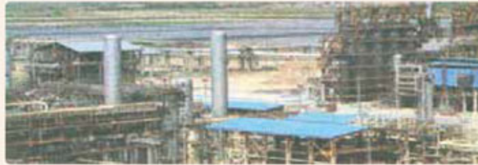
نمایی از یک برج تقطیر برای جداسازی اجزای هوا
